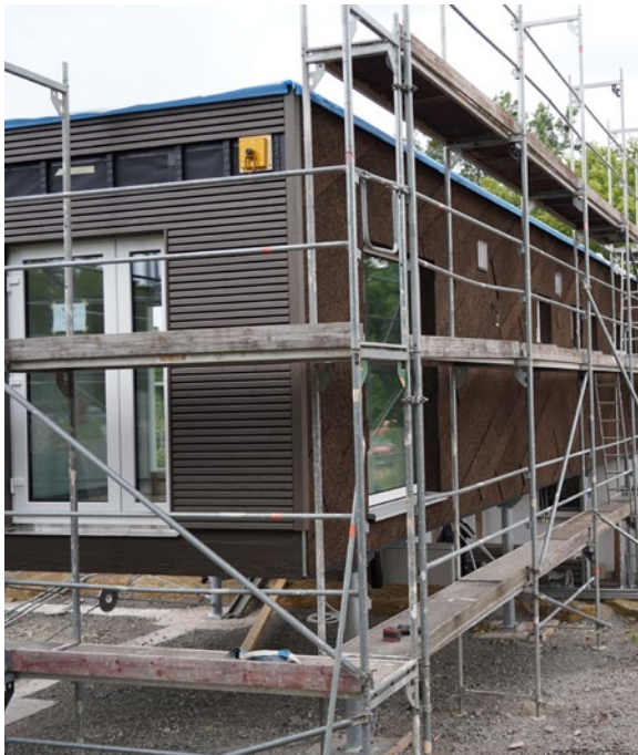
Der Erweiterungsbau des LebensPhasenHauses wird als Modulbau vorgefertigt – inklusive der verschiedenen Fassaden, beispielsweise einer Korkfassade.
