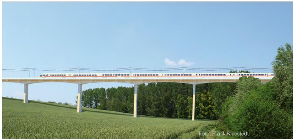
Die Scherkondetalbrücke (576,5 m lang) ist eine zweigleisige Eisenbahnüberführung der Strecke Erfurt-Leipzig-Halle.
