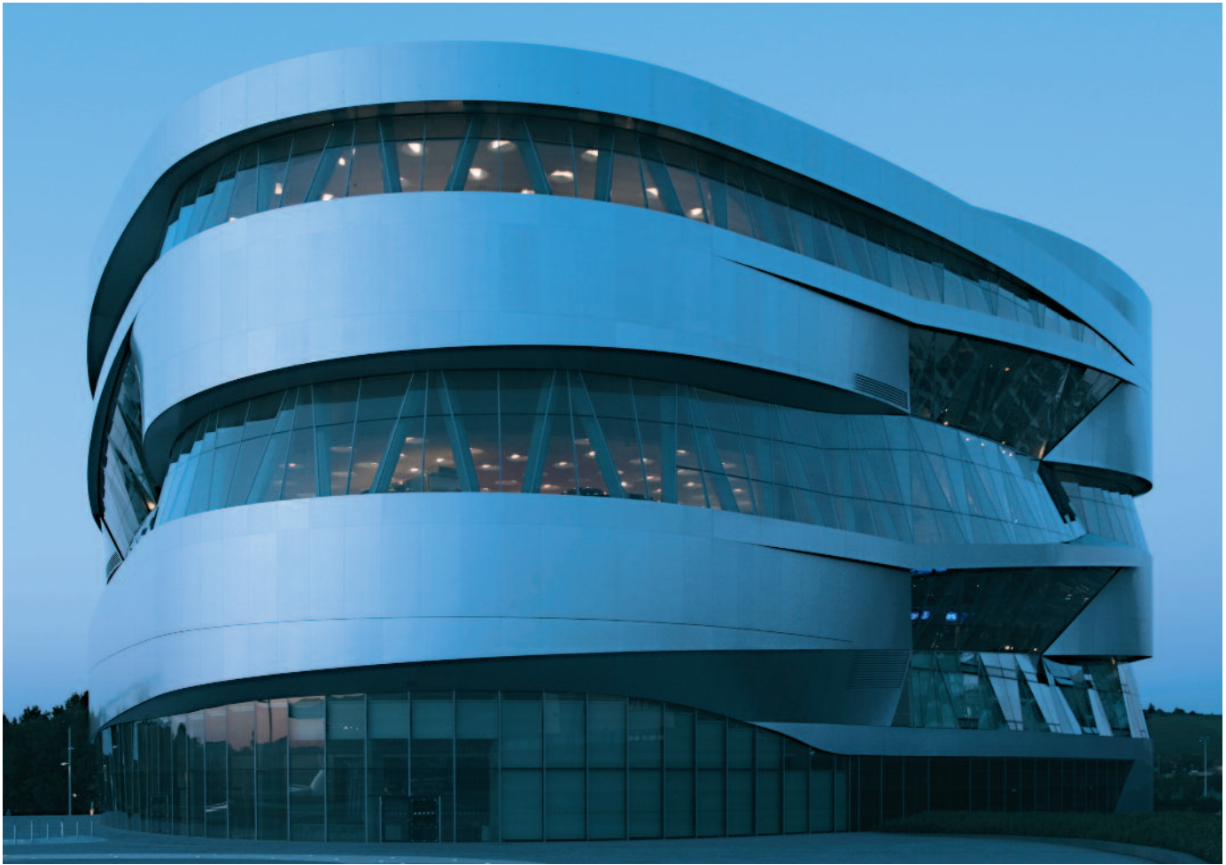
Beim Mercedes-Benz-Museum in Stuttgart wurde durch 3D-Planung die CAM-unterstützte Fertigung von speziell geformter Schalung möglich.
